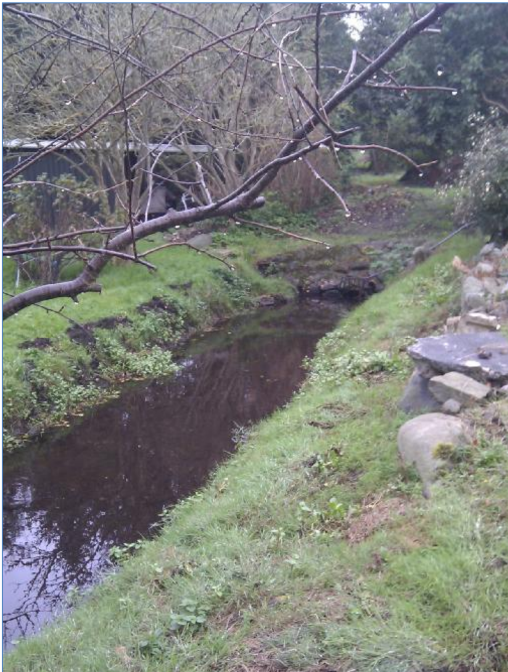
St. 1326 udløb rørlægning
