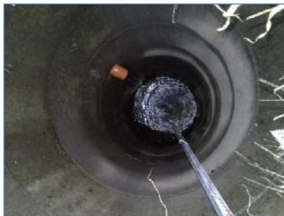
Veddinge Moseløbet, brønd 7, st. 513
