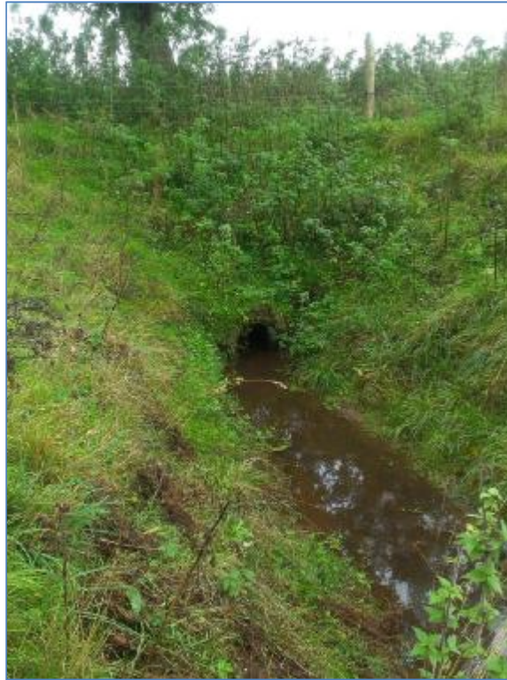
Dragsholmløbet st. 1193 rørindløb
